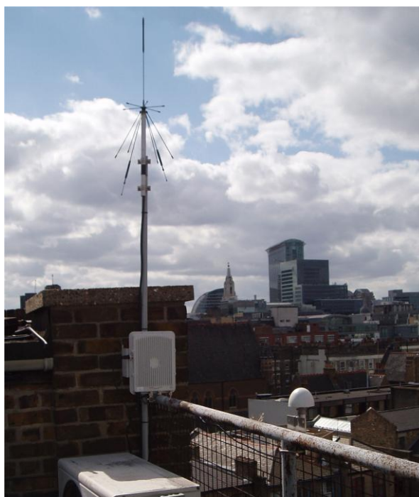
Рис. 3. Типовой вариант установки РЧ сенсора
